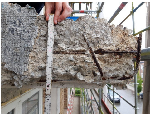
Positie wapening opmeten met plooiometer
