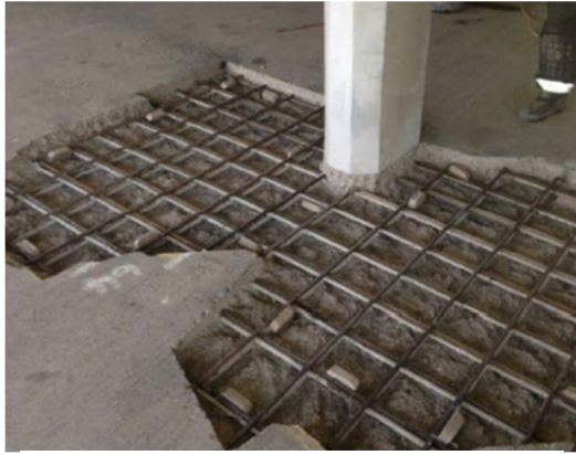
Figuur 12: Plaatsing ingebedde anodes
