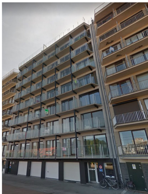
Figuur 20: Uitwendig constructie ter verhoging draagvermogen balkons [Google Maps]
