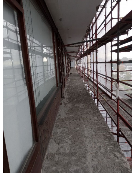
Figuur 9: Balkon waar terrasopbouw en balkonrand verwijderd werden
