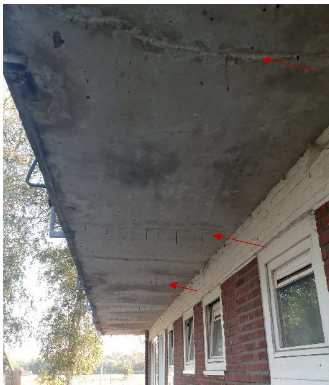
Figuur 17: Stalactieten onderzijde balkon
