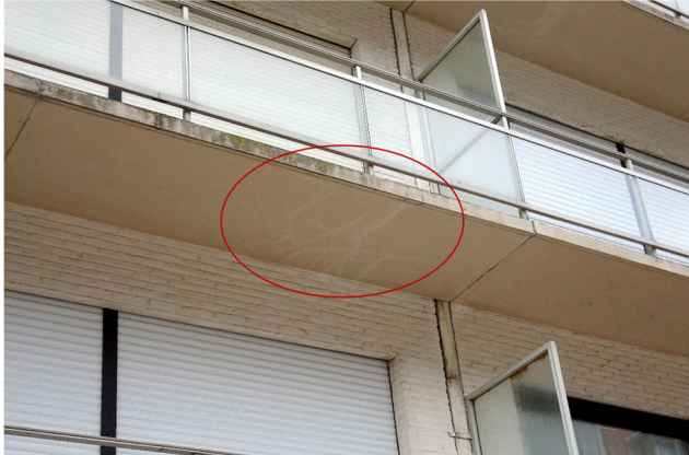
Figuur 18: Scheurpatroon door ASR – overgenomen van [3]
