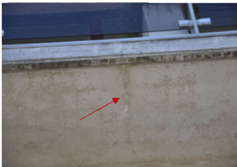
Figuur 13: Krimpscheur
