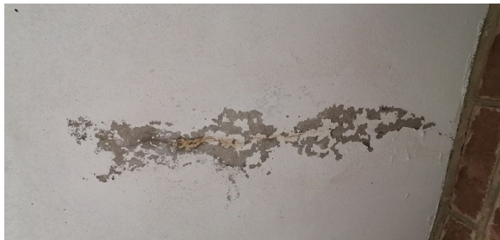
Figuur 14: Krimpscheur
