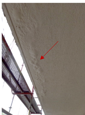
Figuur 8: Blaasvorming coating
